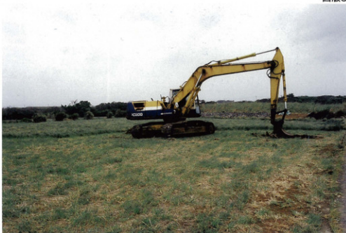
重機による表土剥ぎ
